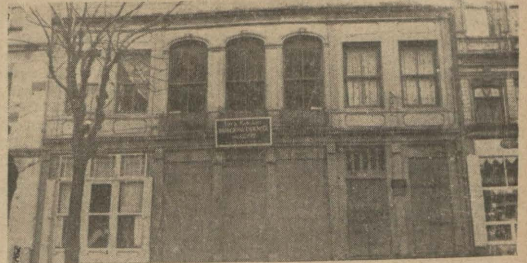
Kadınları Esirgeme Derneğinin binası
